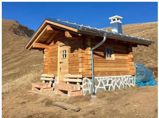
Foto n. 16 - Ricovero in legno per pastori fatto realizzare dalla Comunità della Valsugana e Tesino in loc. Pian dei Cavai, Telve di Sopra. (Foto Archivio Servizio Foreste PAT)
